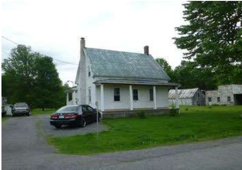
Figure 26 : 50, rang des Patriotes Sud, Saint-Cyprien-de-Napierville. Cette maison est coiffée d'un toit à deux versants droits dont les larmiers effectuent un retour amorçant un fronton sur les murs pignon. Elle est revêtue de planches de bois.
