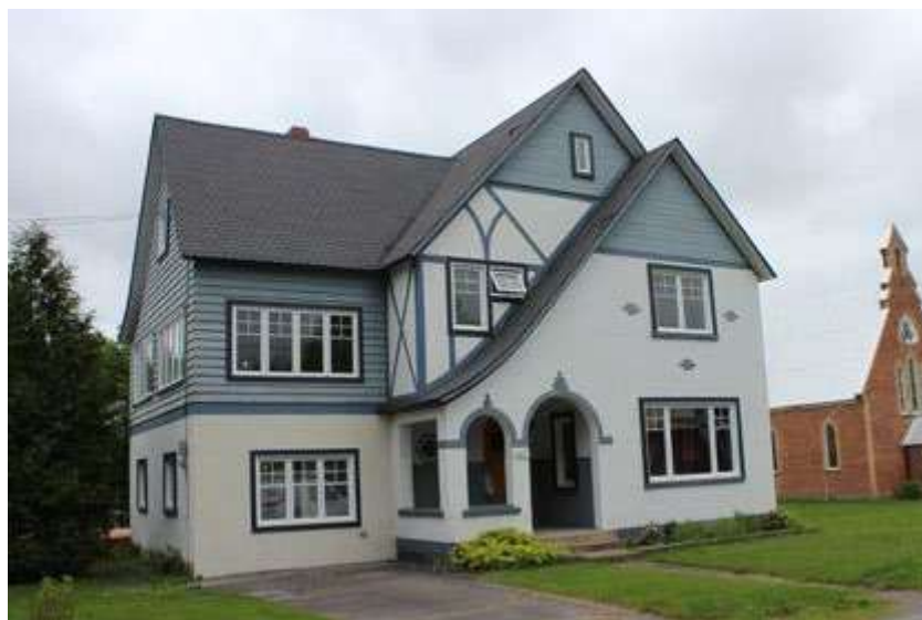
Figure 45 : 527, avenue Champlain, Hemmingford Village. Cette maison cossue est érigée autour de la Deuxième Guerre. Elle se distingue par son volume irrégulier, ses pentes de toit, ses ouvertures diversifiées et ses matériaux.
