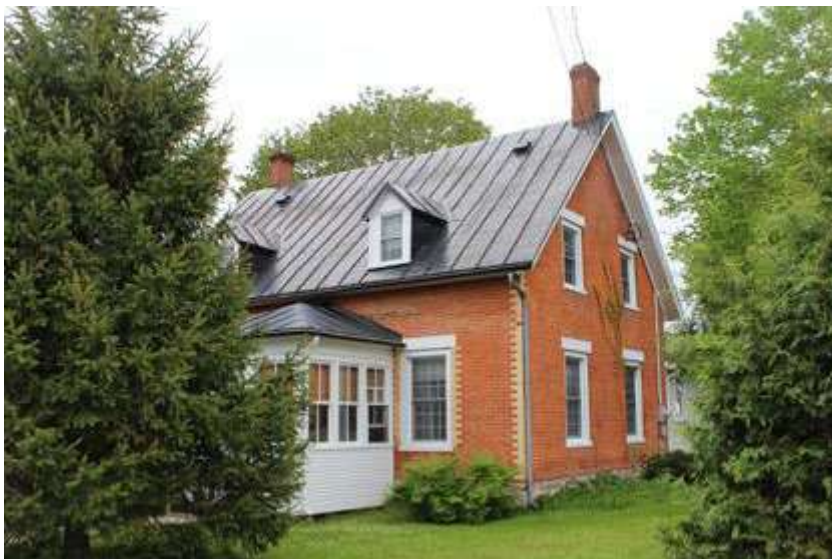
Figure 25 : 482, rue Frontière, Hemmingford Village. Cette maison en brique a le volume typique du cottage vernaculaire américain avec son toit à deux versants droits au larmier court.
