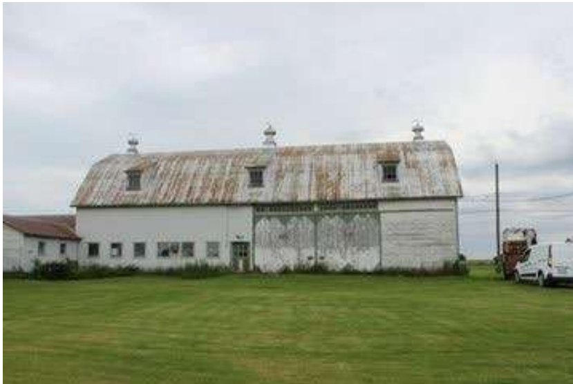
Figure 49 : 39, rang des Patriotes Sud, Saint-Cyprien-de-Napierville. Cette grange-étable à toit brisé se distingue par ses lucarnes en chien assis, ses lanterneaux et ses grandes portes en bois peintes de motifs géométriques.
