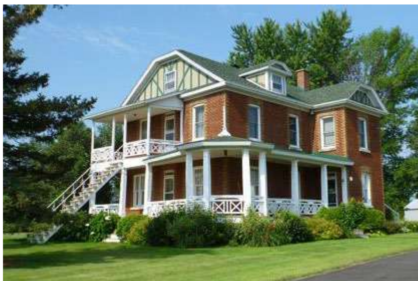
Figure 46 : 300, rue Principale, Saint-Édouard. Cette maison est unique en raison notamment de son volume important, de ses pentes de toit, de ses prolongements extérieurs et de ses faux colombages.
