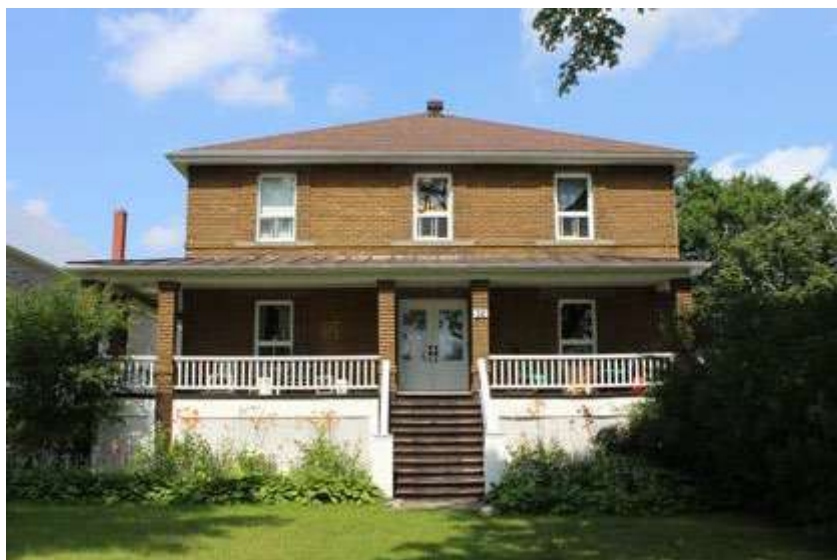
Figure 37 : L'ancien presbytère de Saint-Édouard présente un grand plan carré, une élévation de deux étages et un toit à pavillon (quatre versants) autrefois percé d'une lucarne. Il possède une vaste galerie protégée et une composition symétrique.
