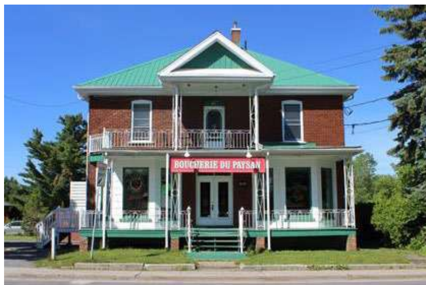
Figure 39 : 315-317, rue Saint-Jacques, Napierville. Cet ancien hôtel profite d'un grand volume rythmé par des fenêtres en saillie, des galeries et une composition symétrique marquée par un fronton.
