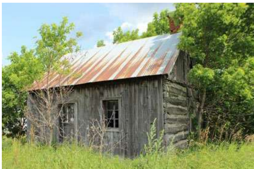
Figure 2 : 433, 4 e rang, Sainte-Clothilde. Cette maison modeste visiblement abandonnée présente une authenticité importante avec son carré de bois en pièce sur pièce visible, son parement de planches de bois verticales et les ouvertures peu nombreuses en bois.
