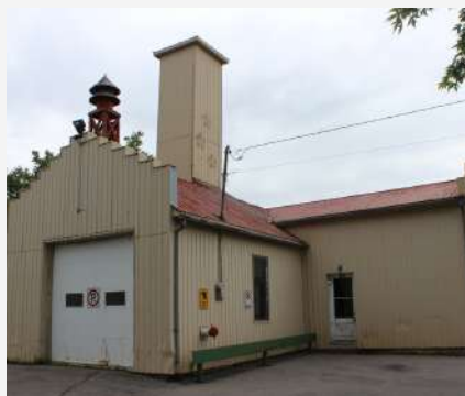
Caserne d'incendie (1950) Saint-Patrice-de-Sherrington
