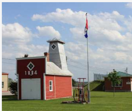
Ancienne caserne d'incendie (1884) Hemmingford Canton
